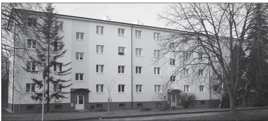
DOMY na Výstavní ulici 2370/16, 2369/18, 2368/20 po opravě.
